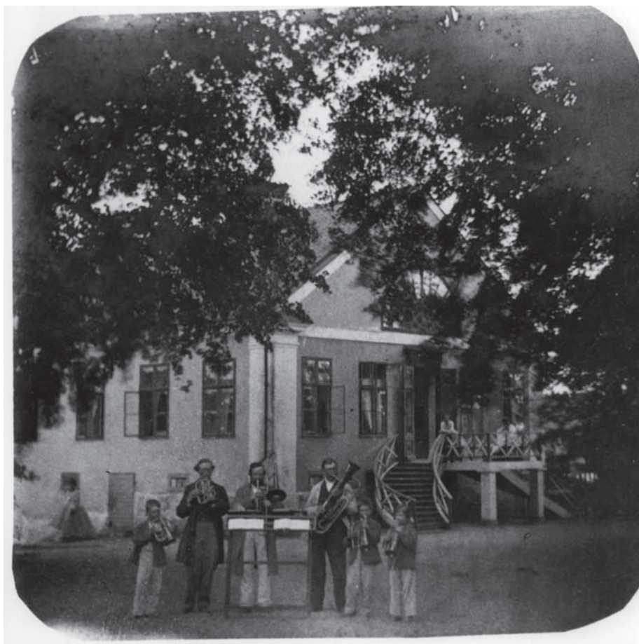
Fig. 8. Holmgrens blåskapell 1865. Vid denna tid var huvudentrén placerad på husets västra gavel. NM
