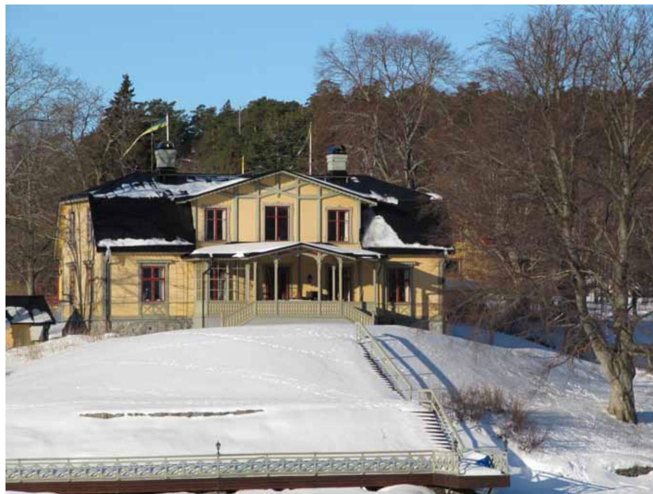
Eriksviks huvudbyggnad har en intressant blandning av gustaviansk stil från sent 1700-tal och det sena 1800-talets strävan till dekorativ panelarkitektur med verandautbyggnader.
