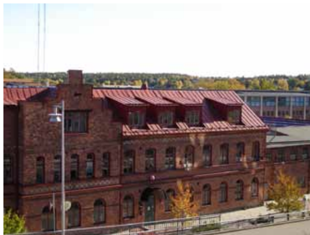
Kontorsbyggnad från 1890-talet. Trappstegsgavlarna är ett medeltida motiv som var populärt vid den här tiden. Slottslänkande arkitektur användes för byggnader som hade en högre status.
