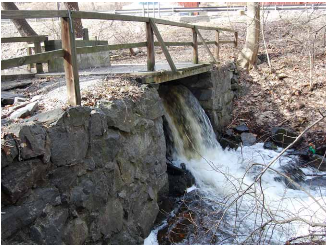
Fördämning med forsande vatten.
