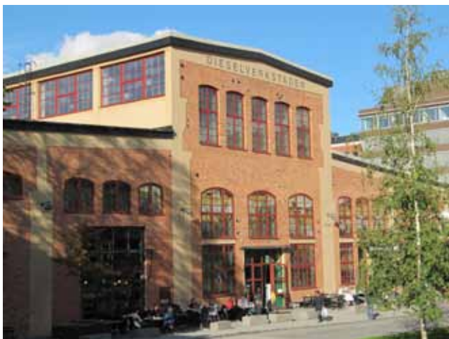
Dieselverkstadens fasad mot Marcusplatsen. Här skedde ihopmonteringen av dieselmotorerna, idag lokaler för bl.a. olika kulturändamål. Den treskeppiga hallen av basilikatyp började byggas 1908, stod färdig i sin nuvarande längd 1911. Den högre delen, mittskeppet, har för ljusföringens skull glaspartier på långsidorna.
