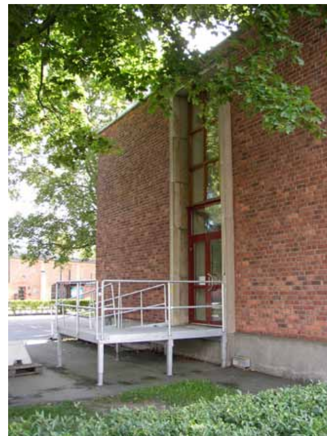
Gavelfasad på affärskontoret från 1939. Byggnaden har ett elegant funktionalistiskt uttryck med vissa kvardröjande drag från 1920-talet.
