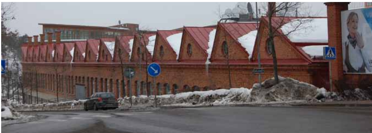
Flera av de äldre industribyggnaderna har karaktäristiska drag så som sågtdandstak och spröjsade fönster. Bildens hallbyggnad är från 1910-talet.
