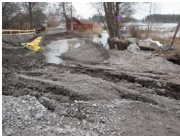
Figur 1. Lerskredet i vägkonstruktionen vid Älgövägen (Nacka kommuns webbplats).
